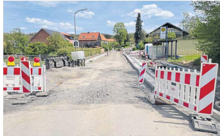
Der letzte Abschnitt der Ortsdurchfahrt von Armenhof wird jetzt von der Alten Heerstraße bis zum Ortsausgang grundhaft erneuert. Ab Mitte Mai soll asphaltiert werden. Foto: Rainer Ickler
